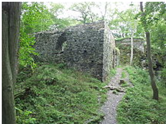
Celkový pohled – vlevo palác, vpravo věž
